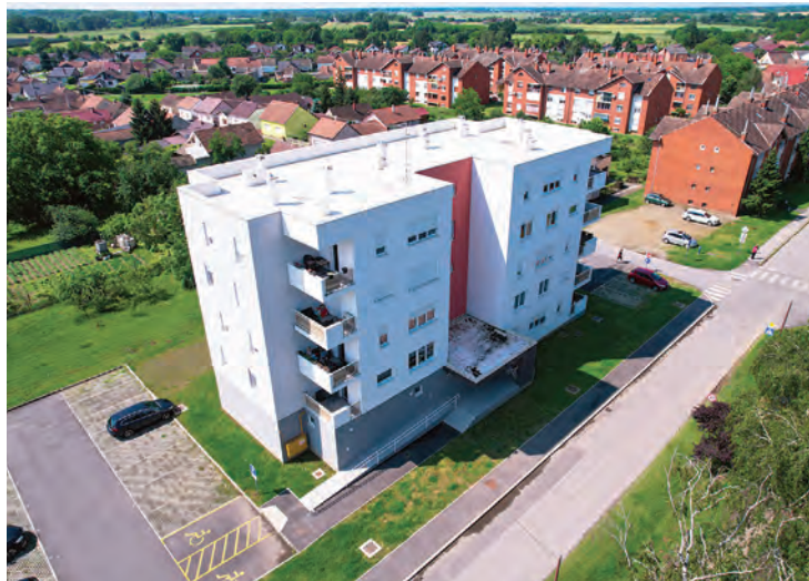
Iduće godine trebala bi početi gradnja i druge POS zgrade
