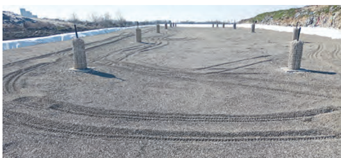
Završena je izgradnja treće (od četiri) kade za odlaganje neopasnog otpada u sklopu V. faze sanacije odlagališta u Belišću
