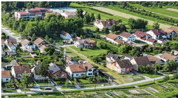
Potez na kojem će se rekonstruirati cesta i pješačka staza
