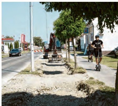
Izgradnja biciklističke staze
