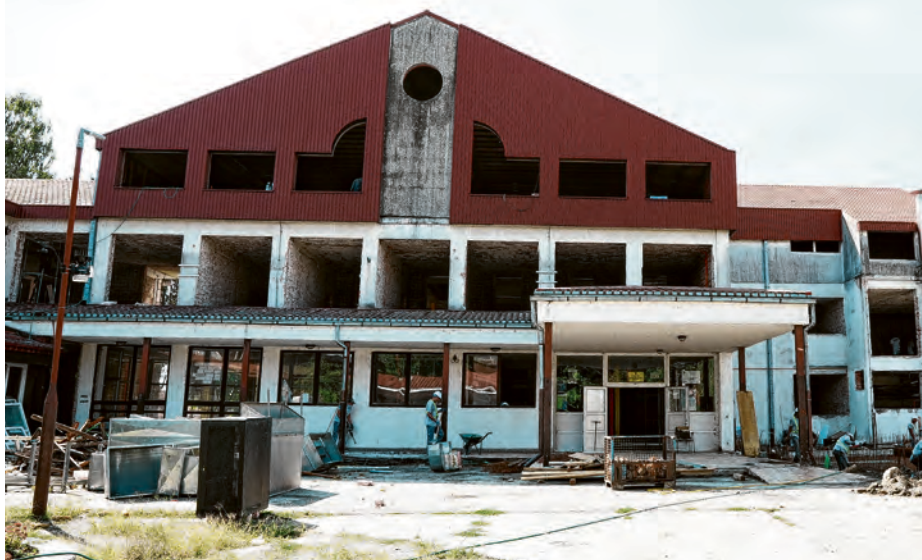
Osnovna škola u fazi je rekonstrukcije i dogradnje
