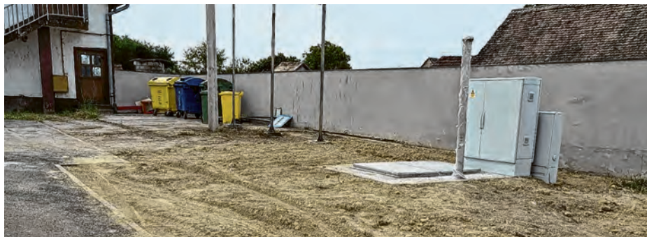
Izgradnja sustava odvodnje otpadnih voda za Bocanjevce je pri završetku
